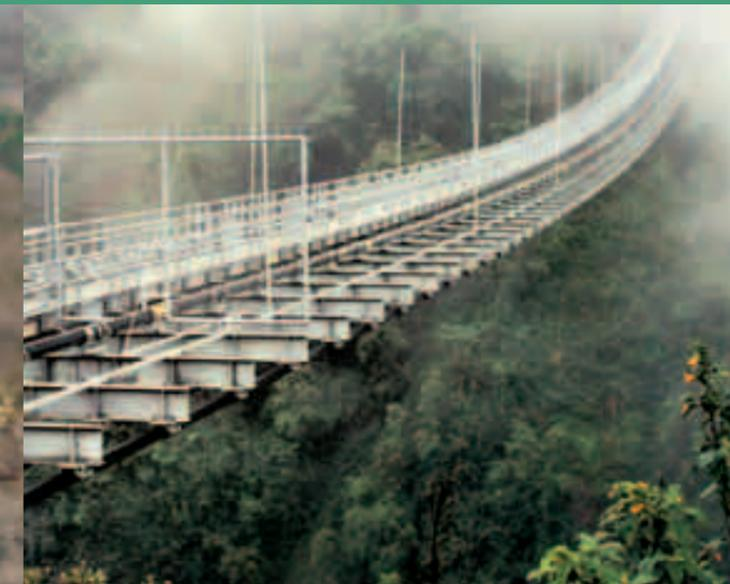
El mineraloducto de 310 km de longitud transporta el concentrado de cobre y oro desde la mina hasta la planta de filtros
