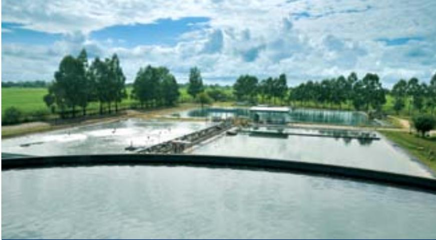
En la Planta de Filtros se extrae el agua del concentrado y se la somete a un proceso de purificación, previo a su descarga en el canal de desagüe pluvial DP2.
