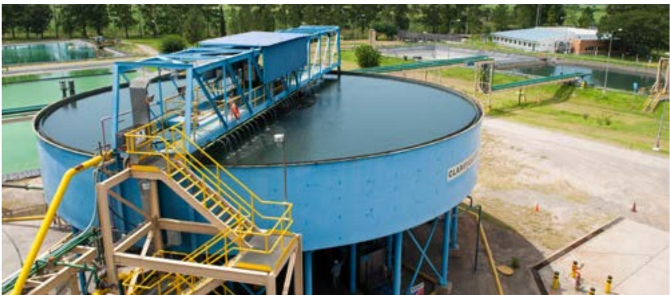
Vista de la Planta de Filtros, Tucumán, donde se extrae el agua para obtener un concentrado más seco, con 7% de humedad.
