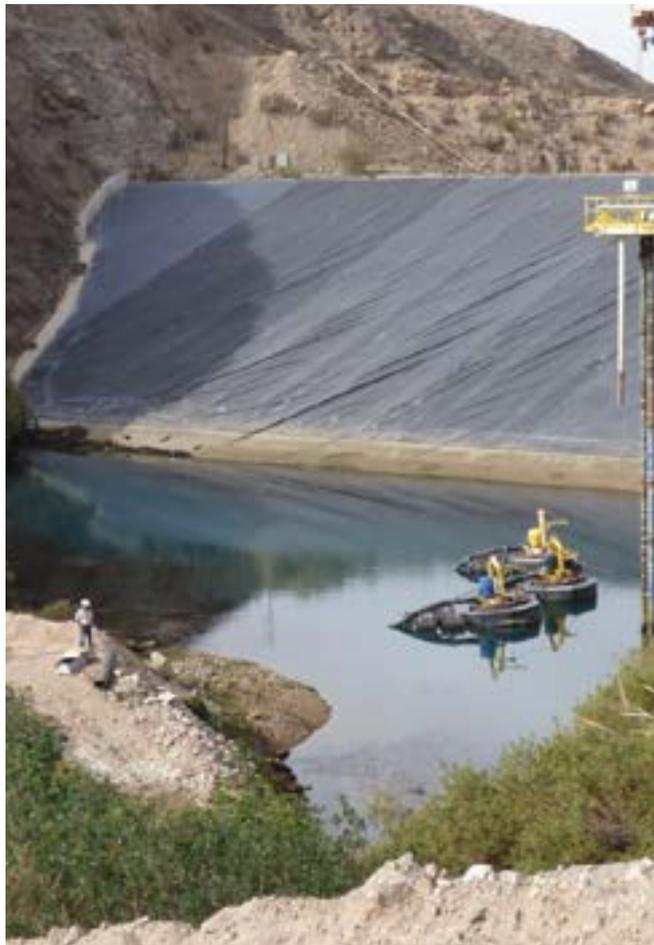
Nuevas bombas instaladas en la laguna colectora de drenajes.
