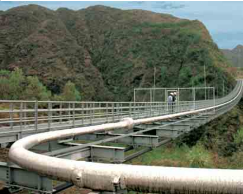
Minera Alumbrera’s 310km slurry pipeline.
