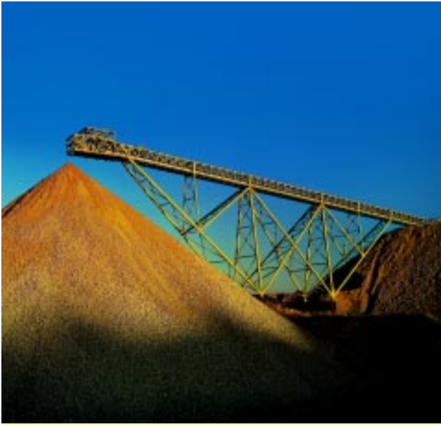
Terminal de descarga del mineral.
