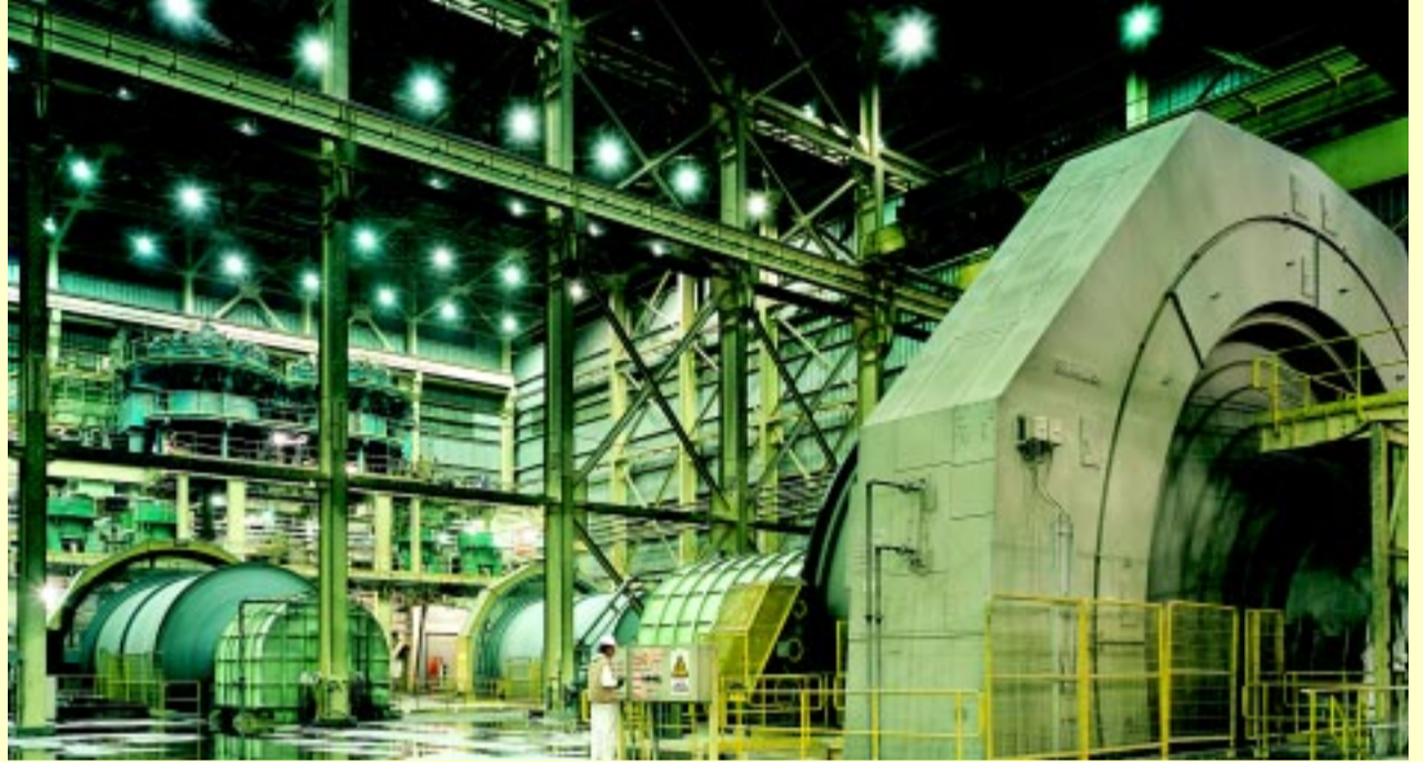
Vista interior del piso de la molienda del concentrador.
