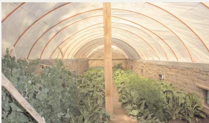
Arriba: construcción del invernadero de Barranca Molle
